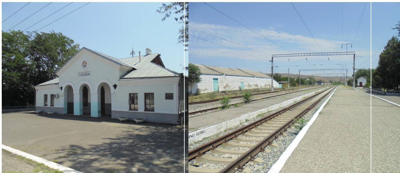
Фото 7.1.1. Жд. станция «Слепцовская» в г. Сунжа, 2017 г.
