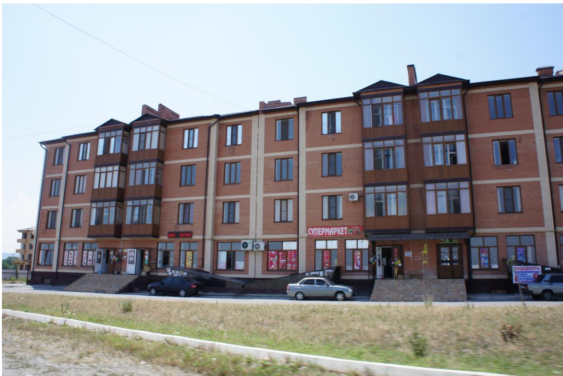
Фото 5.4.1. Многоквартирная жилая застройка по ул. Калинина
