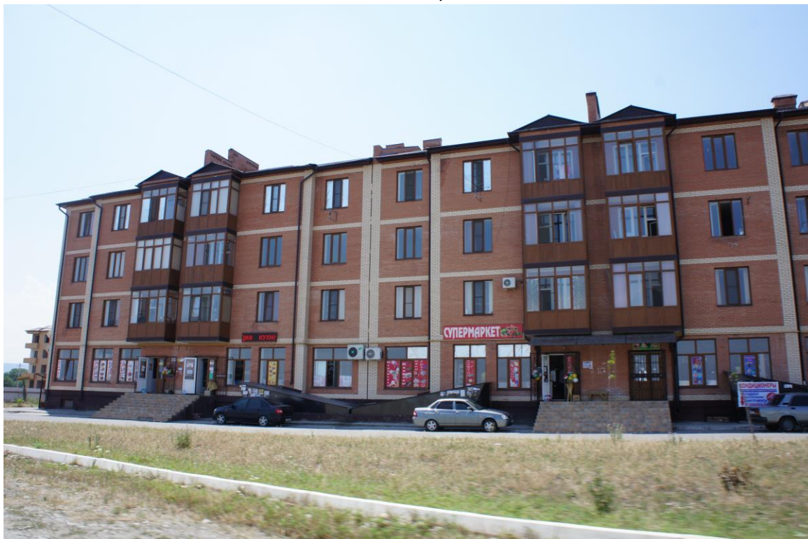
Фото 5.4.1. Многоквартирная жилая застройка по ул. Калинина
